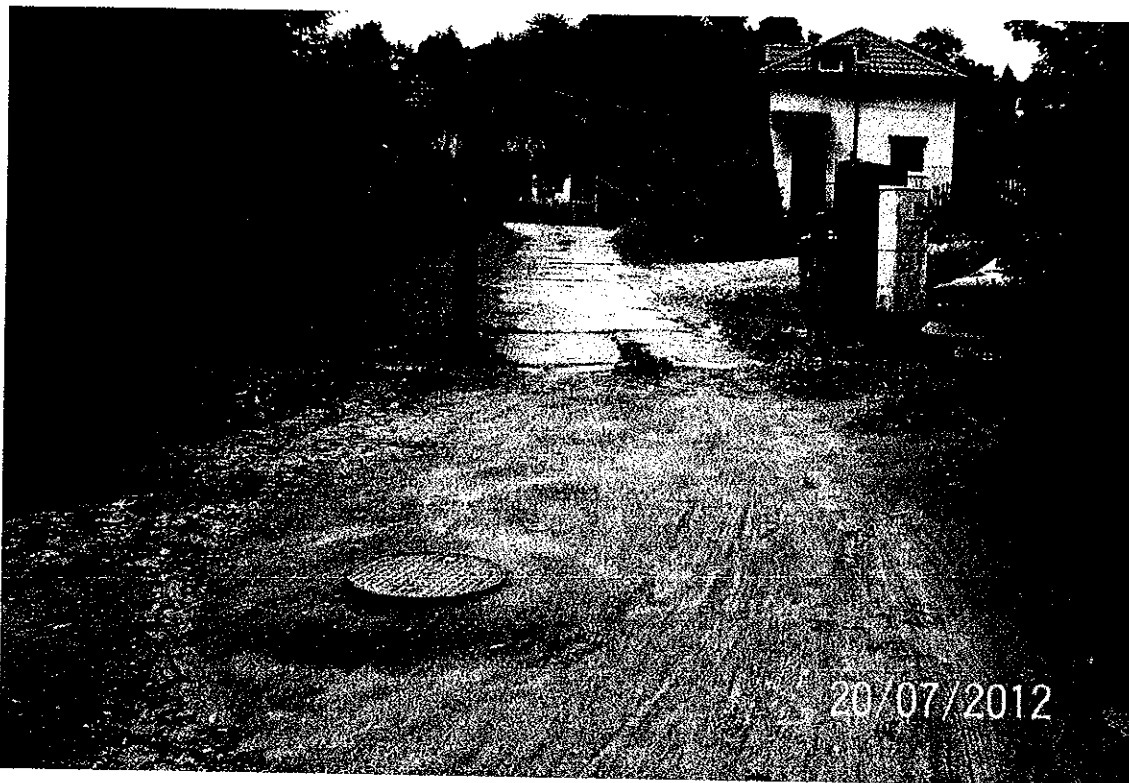
Zal.1 – zdjęcia przedstawiające stan drogi przy ul. Koszalińskiej.
